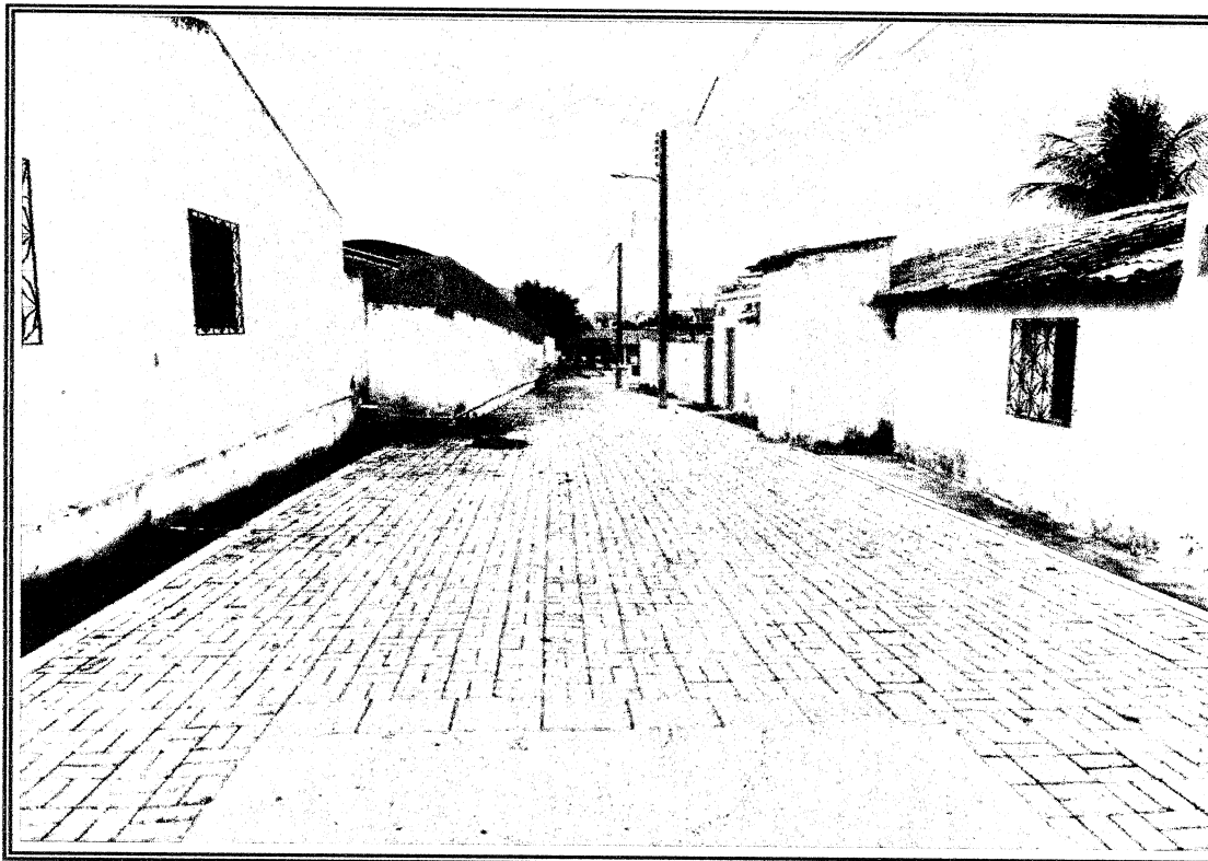
Foto 01 - Vista da pintura danificada.
